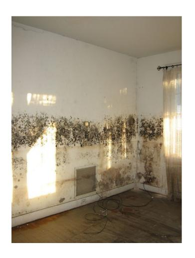
typischer Schimmel bei Wandfeuchtigkeit aufgrund aufsteigender Feuchtigkeit
