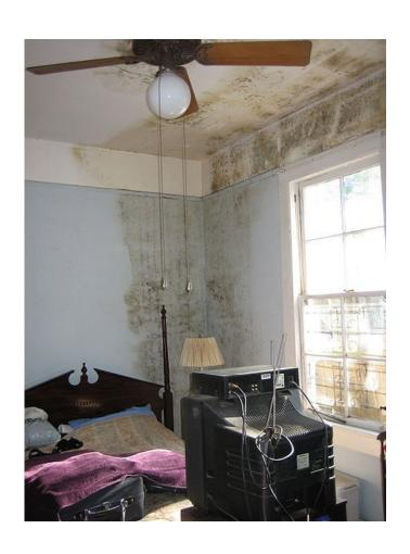
typischer Schimmel bei Wandfeuchtigkeit aufgrund mangelhafter Isolierung
